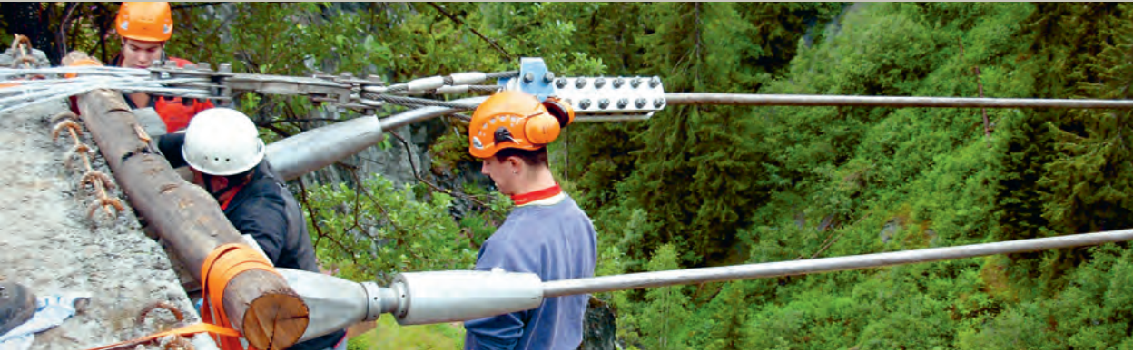
Einziehen und spannen der 44 mm dicken Tragseile (Bild: Corsin Flepp)
