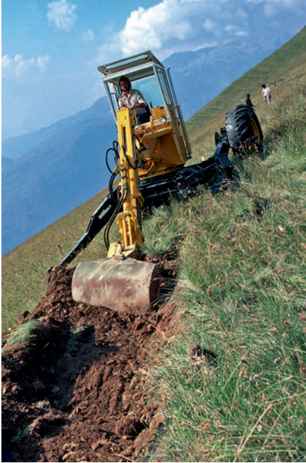
Kleinterrassen (mit Schreitbagger): Mit diesem voll mechanisierten Verfahren können 70 bis 120 cm breite Bermen auf tiefgründigen Böden gebaut werden. Terrassen dieser Breite sind anfällig auf Erosion.
