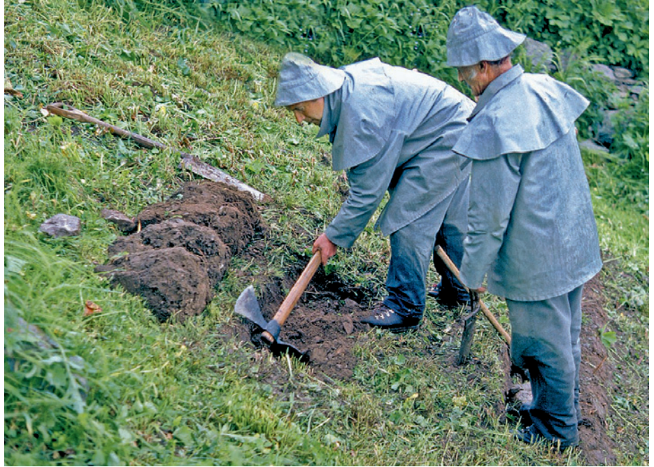
Kleinterrassen (handgefertigt): Voraussetzung für die Handanfertigung ist eine Humusdecke von minimal 20 cm. Das Verfahren erfordert die Zusammenarbeit in einem Zweier-team. Mit einer Wiedehopfhau und einem Spaten werden zwei möglichst zusammenhängende Rasenstreifen abgelöst und übereinander eingebaut. Je nach Tiefgründigkeit der Böden liegt die Breite solcher Bermen bei 50 bis 80 cm.
