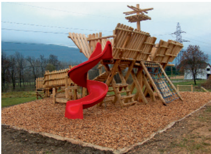
Constitué de copeaux de châtaignier, le revêtement de 40 cm d'épaisseur sous «l'arche de Noé» à Gudo respecte toutes les normes de sécurité.
