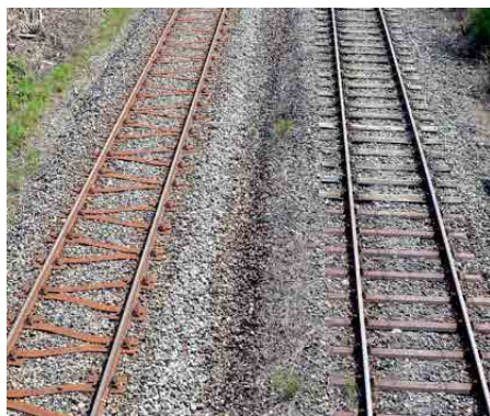
Links Y-Stahlschwellen, rechts hinten Holzschwellen, rechts vorne Trogschwellen aus Stahl (Foto: Wikimedia)
