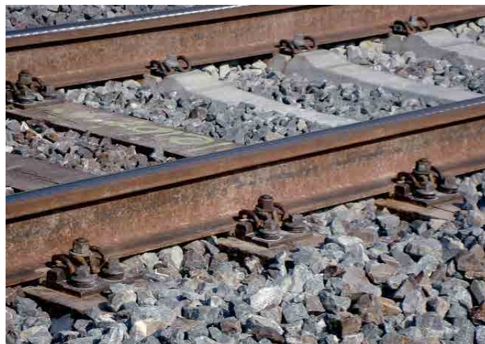
Holzschwellen benötigen im Vergleich zu Betonschwellen zusätzlich zwei stählerne Rippenplatten unter den Schienen samt acht Befestigungsschrauben sowie zwei Nagelplatten an den Stirnseiten.
