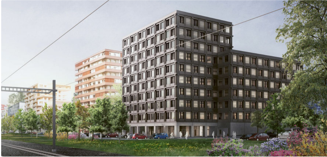
Das erste 10-geschossige Holzhochhaus in der Schweiz – «Suurstoffi 22» in Rotkreuz. Bauherr: Zug Estates AG, Zug | Architekt, Generalplaner: Burkard Meyer Architekten BSA AG, Baden | Holzbauunternehmer, Holzbau- statik und Bauleitung: ERNE AG Holzbau, Laufenburg
