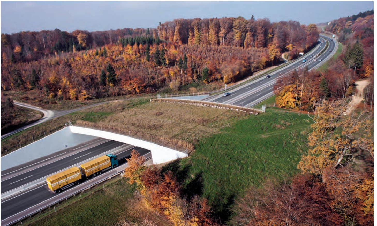
Neu erstellter Wildtierübergang bei Oulens-sous-Echallens (VD) an der A1. Foto: BAFU/AURA E. Ammon
