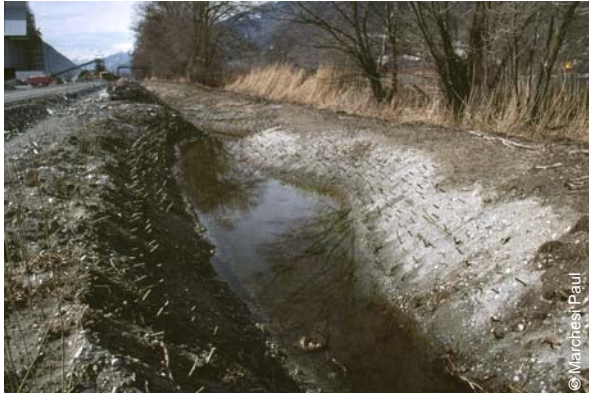
Bei grösseren Baggerarbeiten in Kanälen können tiefere Bereiche („pools“) geschaffen werden (Rarogne VS)
