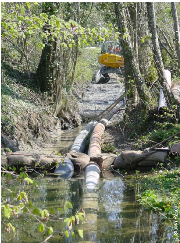
Bei allen Arbeiten in Krebsgewässern müssen Massnahmen gegen Schwebstoffbelastungen getroffen werden (Cuarny VD)
