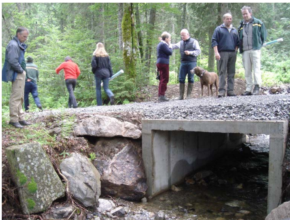
Fertige Rahmenbrücke: Besichtigung mit dem Projektbeirat, Ansicht vom Unterlauf; 16.07.2007
