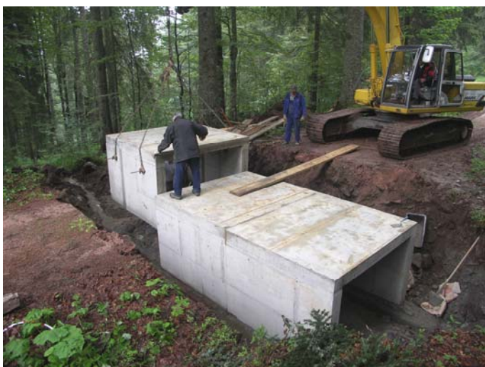
Im Bau: Versetzen der Rahmenelemente; 02.06.2007
