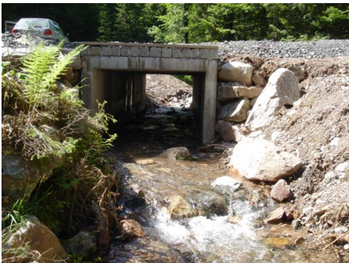
Nach Fertigstellung: Brücke in Rahmenbauweise, Ansicht vom Unterlauf; 24.05.2007
