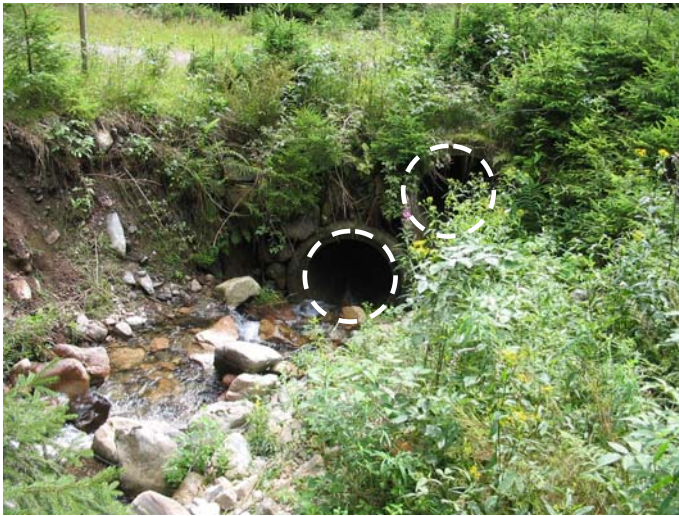
Vor dem Umbau: Querung aus zwei Rohren DN 1000 (Markierung), Ansicht vom Oberlauf; 21.06.2006
