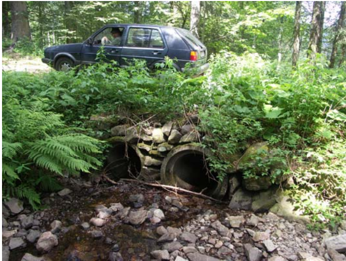
Vor dem Umbau: Querung aus zwei Rohren DN 600/DN 700, Ansicht vom Oberlauf; 11.07.2006
