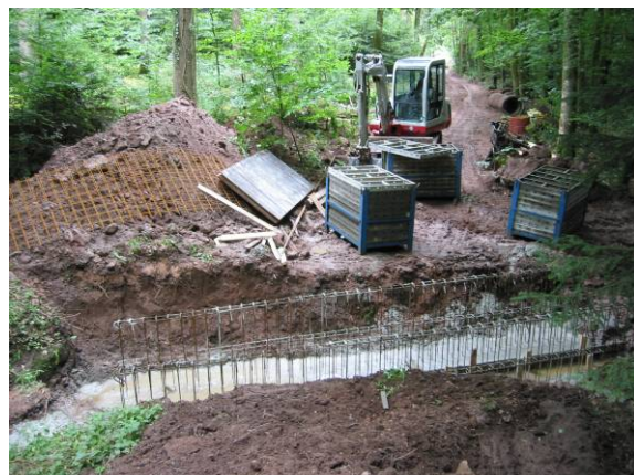
vue générale du chantier
