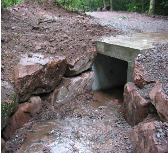
tête du nouvel ouvrage
