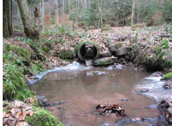
vue de l'ouvrage busé (avant)
