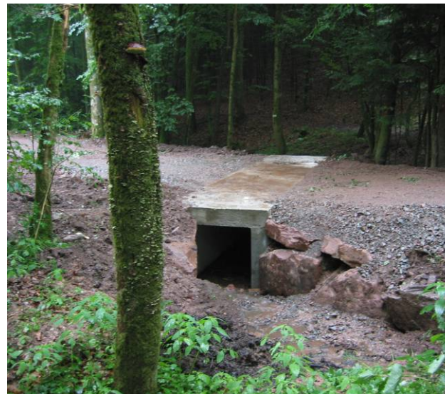
vue générale du nouvel ouvrage
