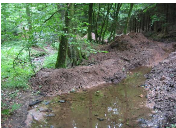
fossé de déviation du ruisseau pour travail hors d'eau
