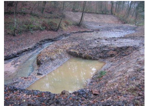
le nouveau lit qui s'est reconnecté à la mare, 15 jours après les travaux (décembre)
