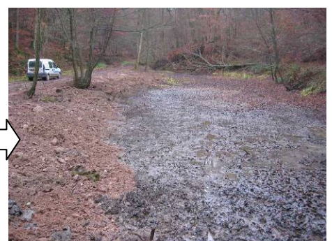
post travaux (décembre)
