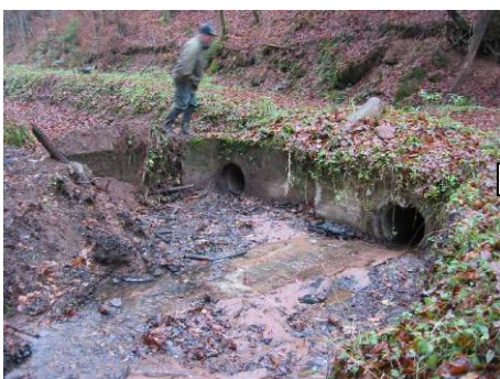
fermeture de ouvrage de répartition à l'amont durant les travaux (novembre)
