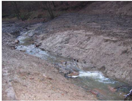
au niveau de l'ancienne digue, 15 jours après les travaux (décembre)
