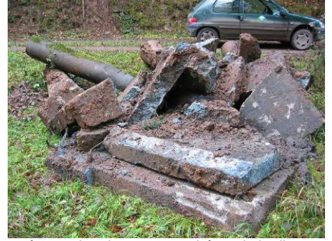
évacuation des ouvrages béton de la digue (novembre)
