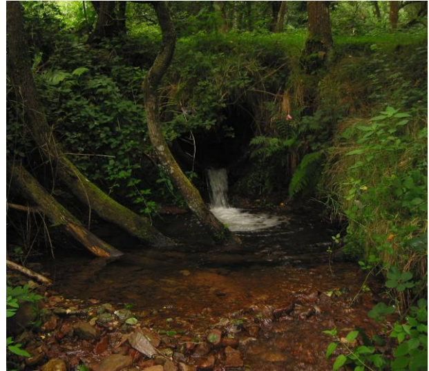
buse n°2 secteur aval du Luttenbach Avant travaux
