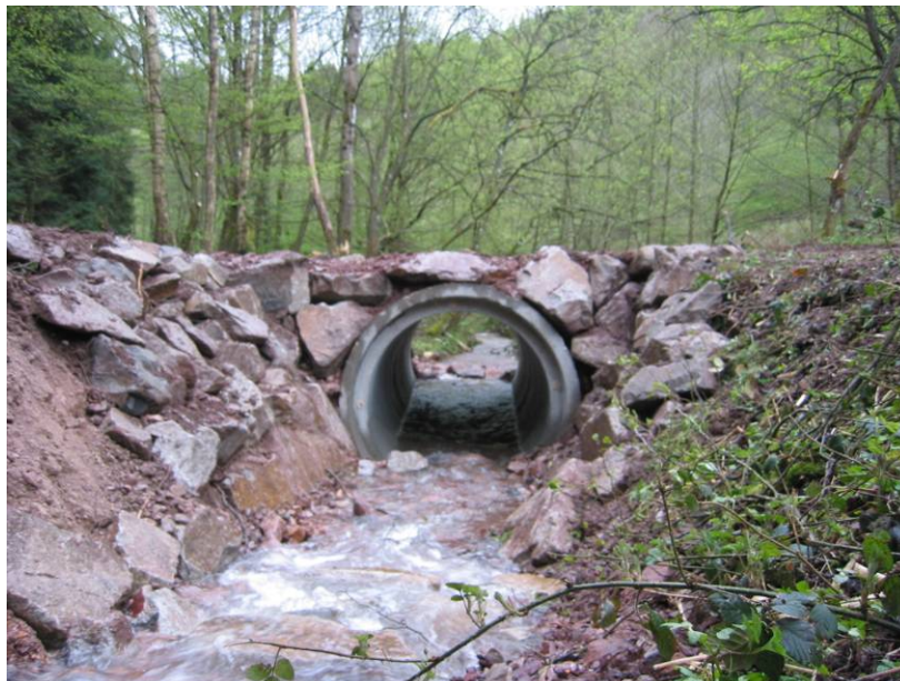
vue en entrée de buse du nouvel ouvrage buse n°2 secteur aval du Luttenbach
