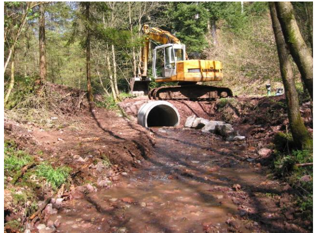
mise en place des tronçons (buse n°1)
