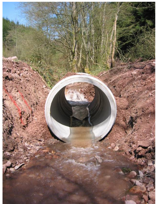
pose de la buse aval après décaissement de l'ancienne ouvrage et profilage du lit (buse n°2)
