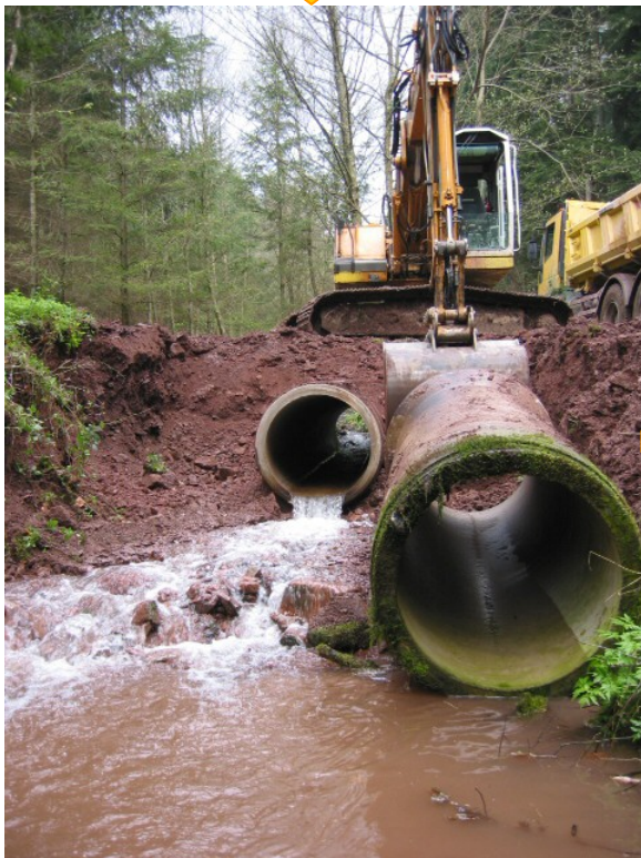
décassement de la buse n°1 amont
