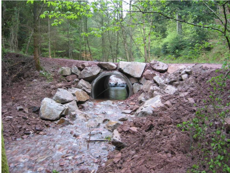
vue en sortie de buse du nouvel ouvrage buse n°1 secteur amont du Luttenbach
