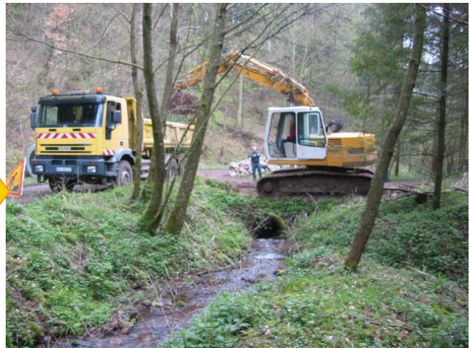
vue du chantier et panneaux de signalisation lors de la phase de décaissement (buse n°1)
