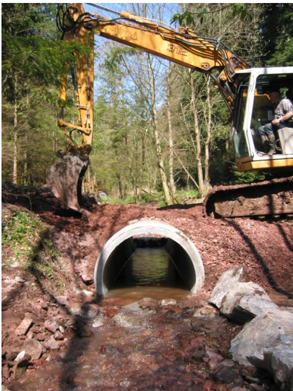
remblaiement de l'ouvrage (buse n°1)
