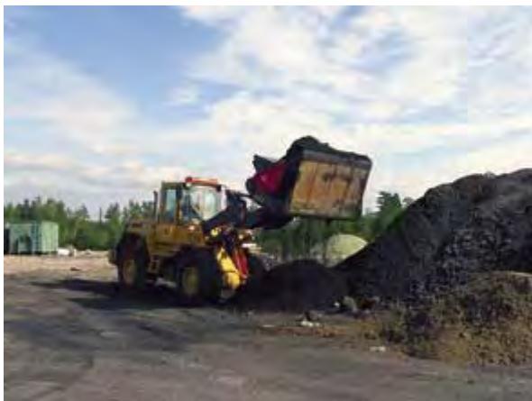
Abb. 8: Schaufellader beim Zerkleinern von gehärteter Asche. Die Schaufel ist mit Brechzylindern ausgestattet (Emilsson 2006).
