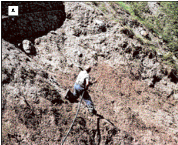
Foto 2 - Idrosemina: (A) su un terreno difficilmente accessibile è stato sparso un miscuglio di sementi con fertilizzanti liquidi e collanti. (B) anche la pista di sci, in zona alpina, dopo l'idrosemina è stata coperta di uno strato di paglia.
