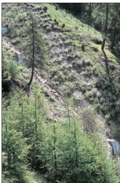
Foto 4 - Ingegneria naturalistica e selvicoltura: stabilizzazione dei versanti laterali di un torrente in una zona al limite del bosco. L'intervento è costruito per mezzo di gradonate vive di salice e di un rimboschimento di abete rosso e larice (in primo piano).
