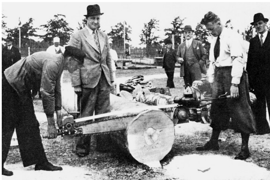
Bild 5: Die Vorführung der Stihl BD 1937 vor Fachleuten. Zur Bedienung gehören 3 Mann, 2 an der Motorsäge, der Dritte musste durch Keilen das Einklemmen des Schwertes mit Schutzstange verhindern.
