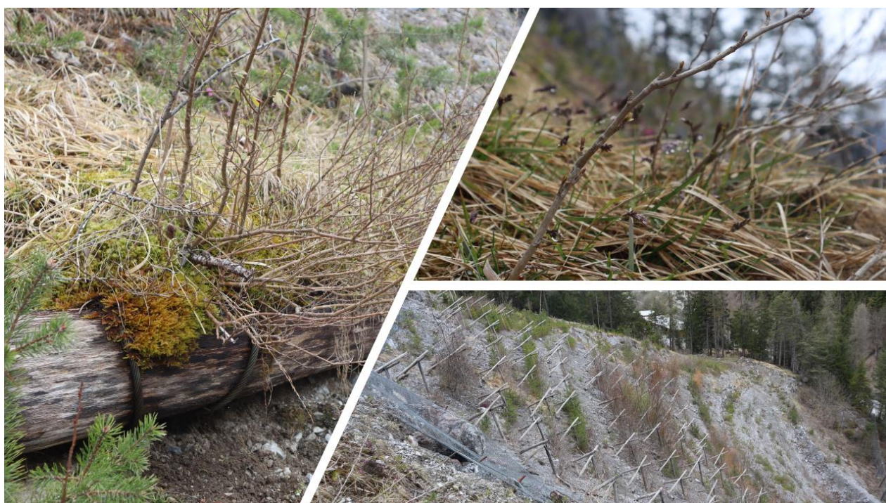
Titelbild: Technische Massnahmenmöglichkeiten gegen Schneegleiten in Trin Porclis (GR) (N.Brodbeck/ WSL, 2023)
