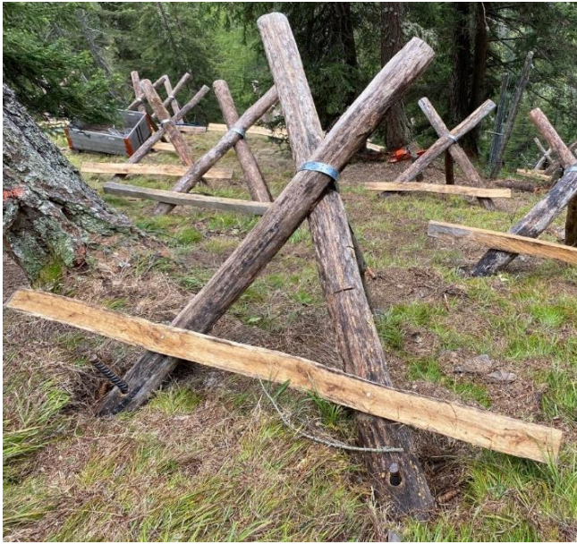
Abbildung 5: Dreibeinbock mit Bodenschwelle (A. Arquint/ Leiter Forstamt Samnaun, 2023).
